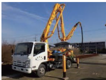
工事：ピストン車の圧送音対策 現場：コンクリート打設（公共工事）
